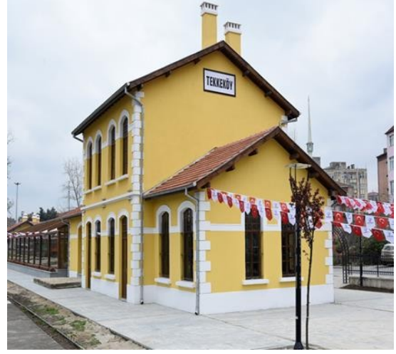
Resim 5. Gar İstasyonu Restorasyon Sonrası (Tekkeköy,2021)
